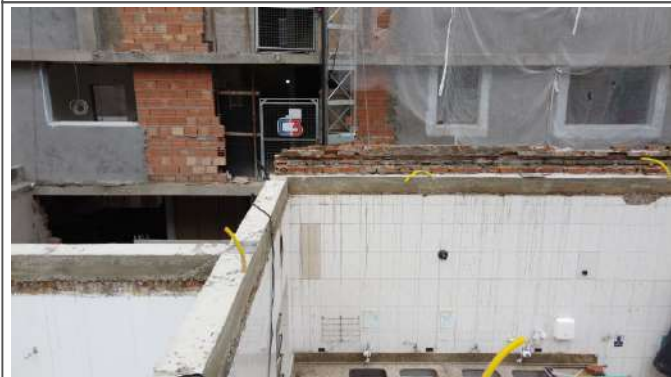
CINTA DA EDIFICAÇÃO CONCRETADA
