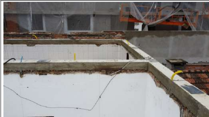
CINTA DA EDIFICAÇÃO CONCRETADA
