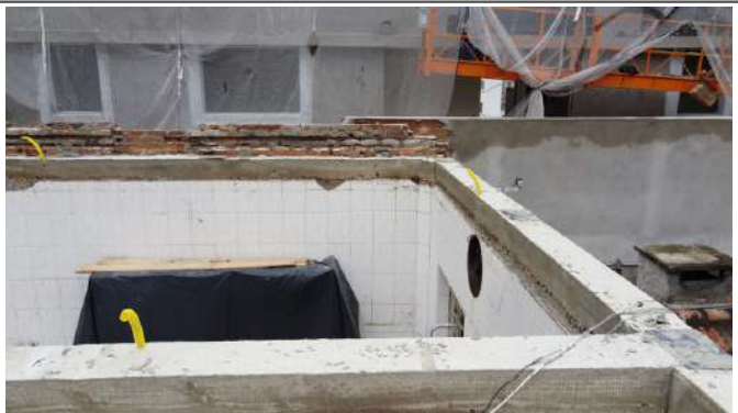
CINTA DA EDIFICAÇÃO CONCRETADA
