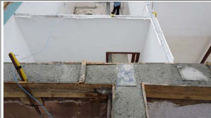
CINTA DA EDIFICAÇÃO CONCRETADA
