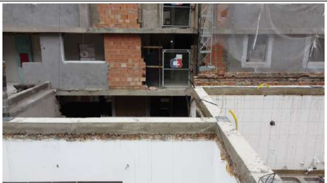
CINTA DA EDIFICAÇÃO CONCRETADA
