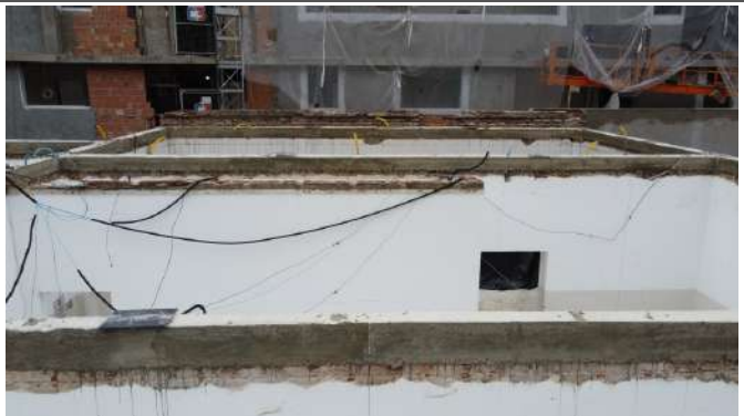
CINTA DA EDIFICAÇÃO CONCRETADA
