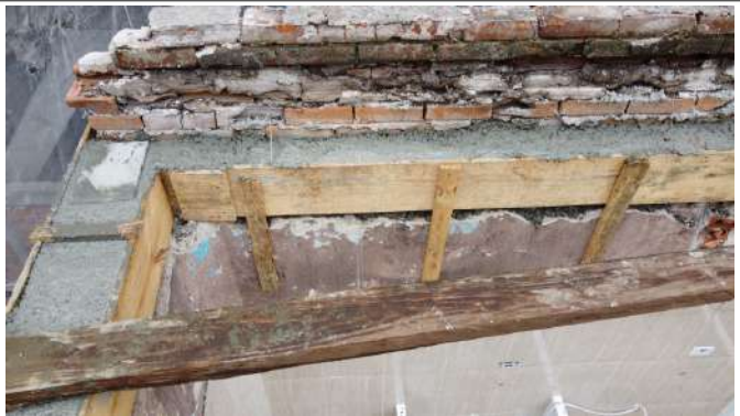
CINTA DA EDIFICAÇÃO CONCRETADA
