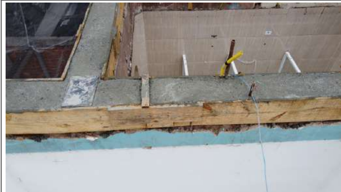
CINTA DA EDIFICAÇÃO CONCRETADA
